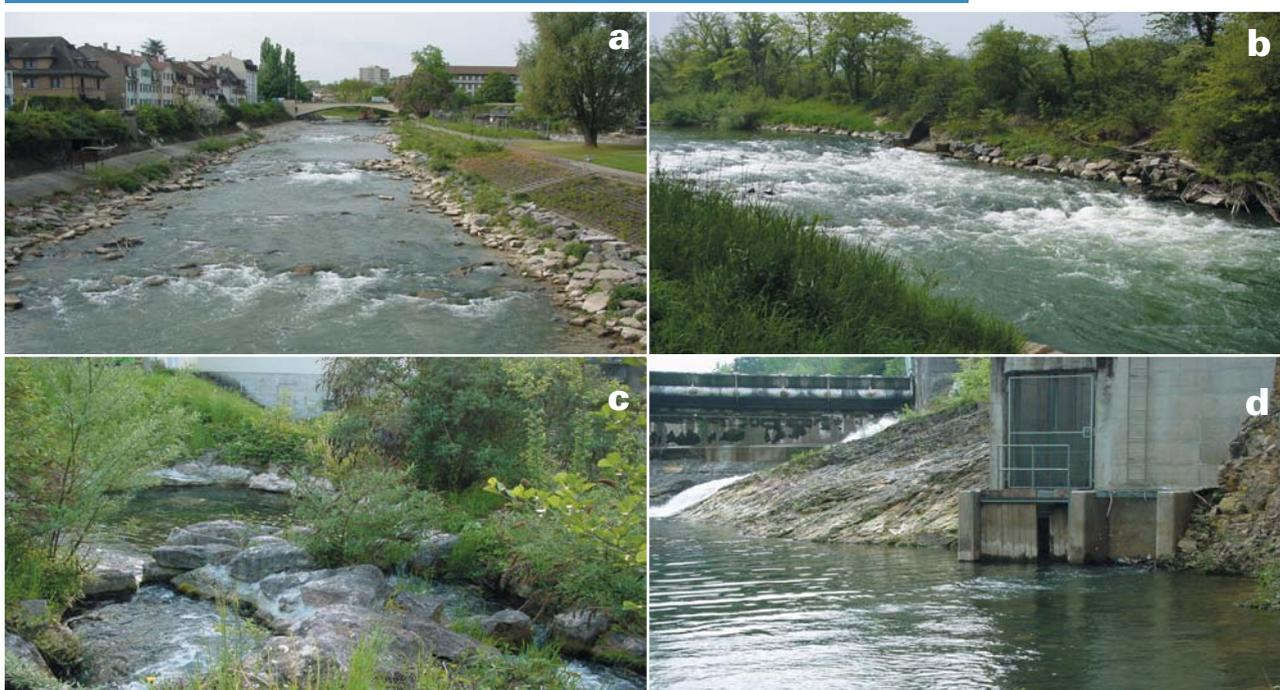
Abb. 8: Massnahmen an der Birs zur Verbesserung der Durchgängigkeit. **a:** Schwellensanierung Unterlauf (Stadtbereich Birsfelden); **b:** Schwellensanierung unterhalb Heidebrüggli; **c:** Umgehungsgerinne des Wehres Moos bei Grellingen; **d:** Einstieg zum Fischlift am Wehr der Grellinger Papierfabrik.
